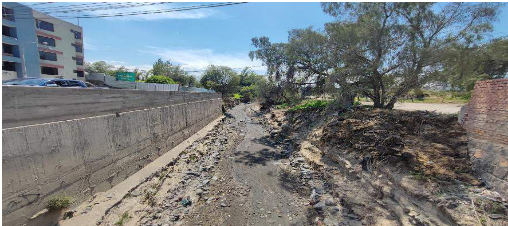
IMAGEN 01: SE OBSERVA LA MARGEN IZQUIERDA DE LA QUEBRADA SIN PROTECCION SE REQUIERE DE LA CONSTRUCCION DE MURO DE CONCRETO ARMADO
